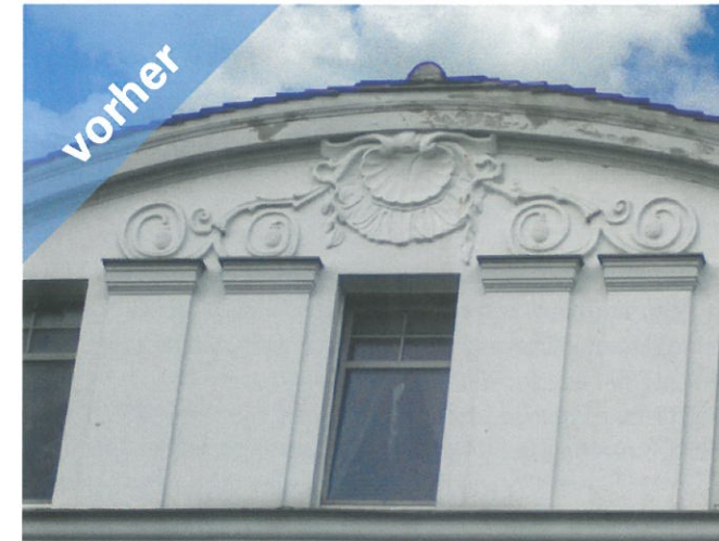
Die Farbe blätterte ab, der Putz war porös. Die Rundung unter dem Dach wurde komplett neu gestaltet.
