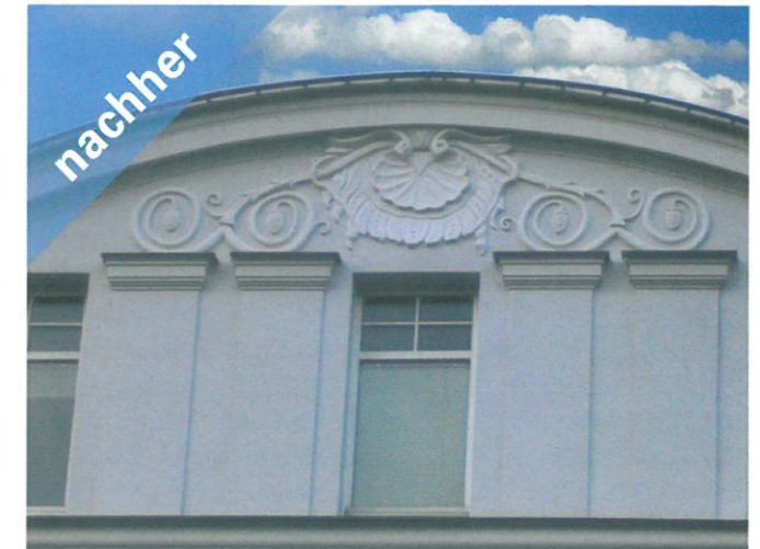
Die Farbe blätterte ab, der Putz war porös. Die Rundung unter dem Dach wurde komplett neu gestaltet.
