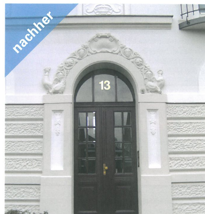
Heute wirkt die Fassade durch die leicht wärmere Farbgebung deutlich einladender.
